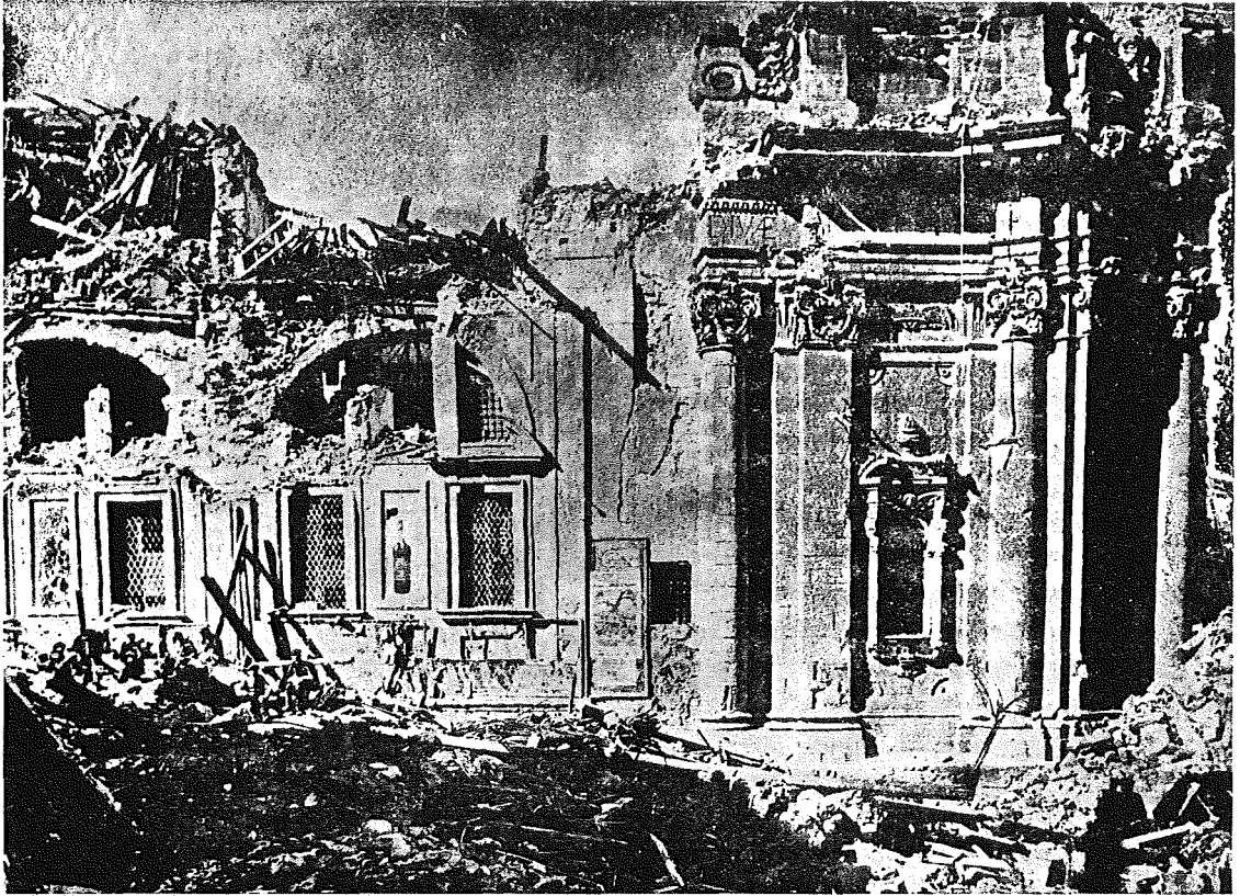
Fig. 4 - Particolare dell'Annunziata e del Convento dei Teatini con i danni del terremoto del 1908.
